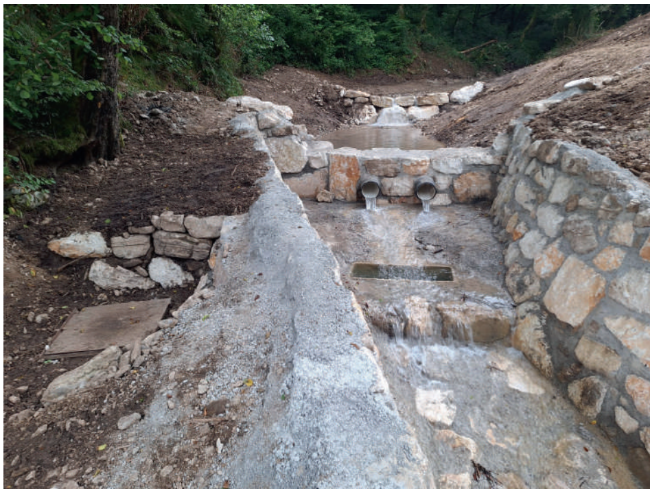
Sistemazione del torrente in Val Saino
