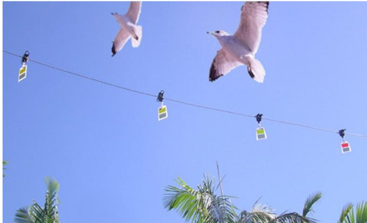
Fig. 40 - Esempi di flight diverters da applicare ai cavi elettrici
