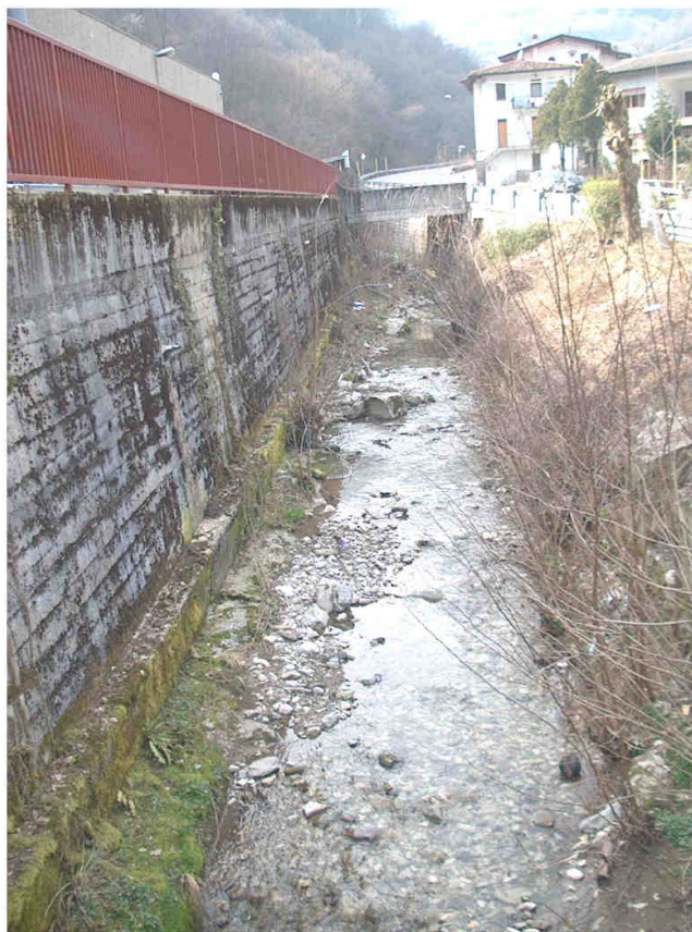
Fig. 26 – Visuale sovrappasso idraulico del torrente Gombiera a Cortivaz – Località Gombio
