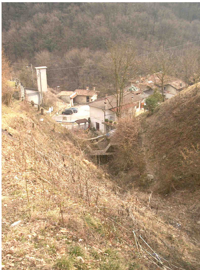
Fig. 27 – Visuale sovrappasso idraulico del fosso di Mogazzo, località Gombio
