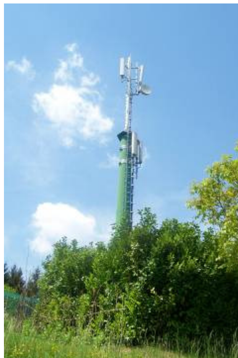
Antenna via Castignidolo
